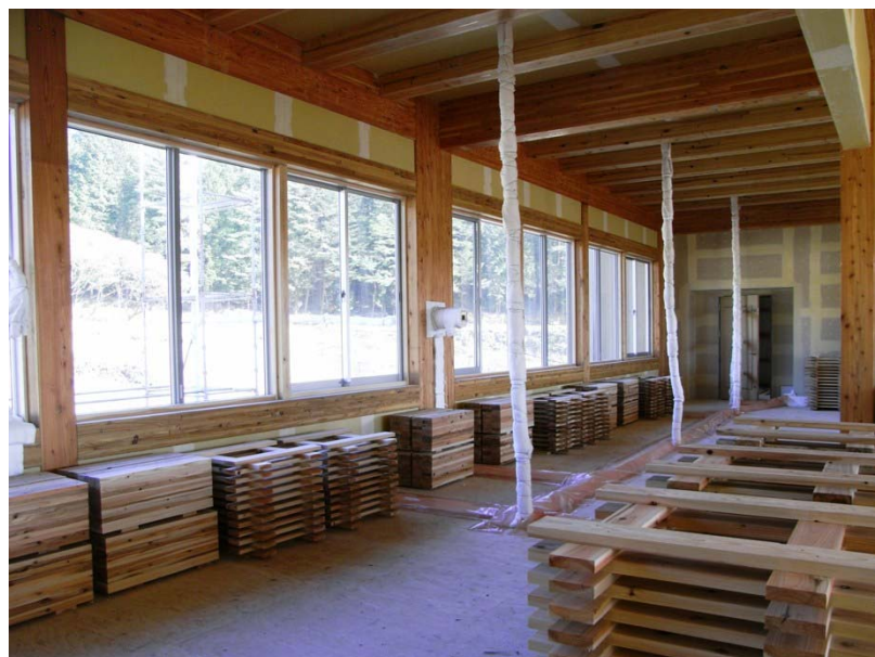
2階 教室オープンスペース
