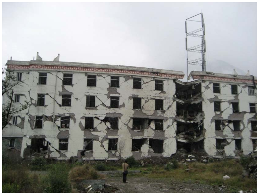
1階が崩壊した学生寮(四川省映秀)
