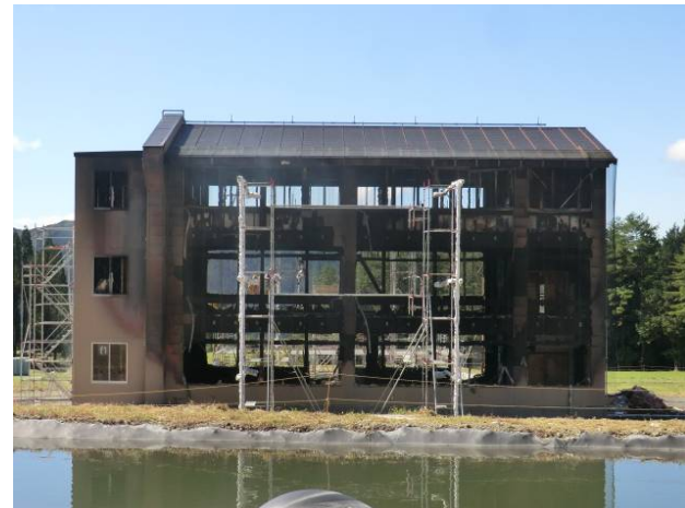
【写真6】北側外観(実験日翌日撮影)
