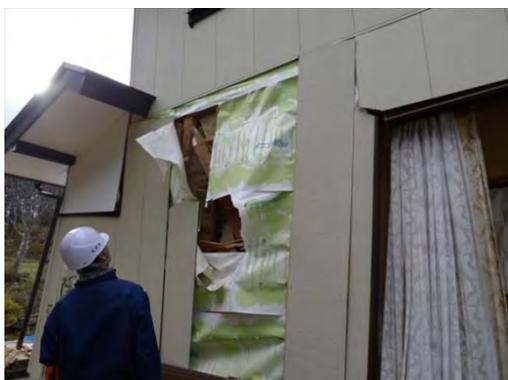
写真 5.3.10 筋かいが確認された壁の外装材の脱落
