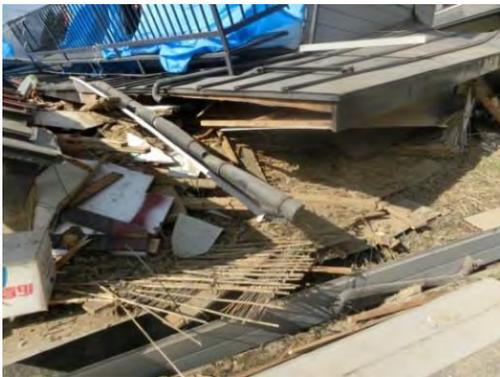
写真 5.1.14 倒壊した住宅の土塗り壁
