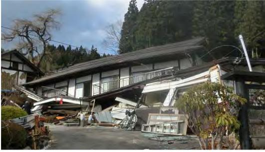
写真 5.2.4 倒壊した住宅
