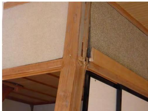
写真 5.3.7 差鴨居部での柱の折損
