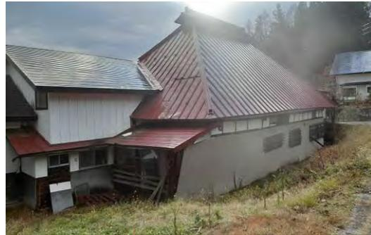
写真 5.2.13 山側への残留変形が大きい住宅
