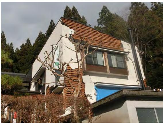
写真 5.2.9 モルタル外壁が剥落した宿泊施設
