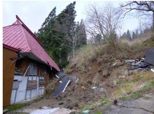
写真 6.1.2 建築物背面の土砂崩れ
