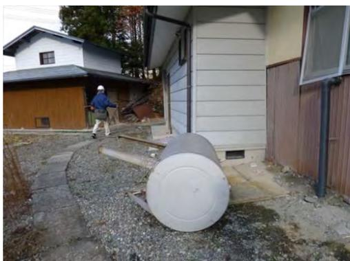
写真 5.3.24 灯油タンクの転倒
