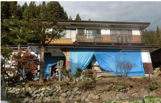
写真 5.2.14 東（写真右）へ傾斜した住宅
