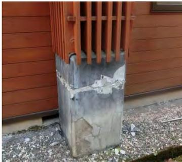
写真 5.2.3 鋼管脚部の損傷
