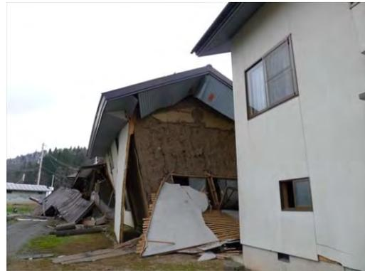
写真 5.3.4 既存部の土蔵の被害
