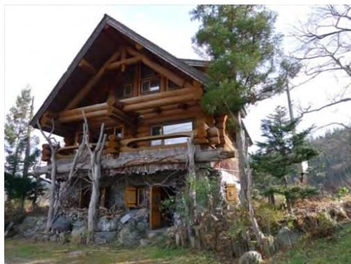
写真 5.3.21 1F RC+2階ログハウスの建築物
