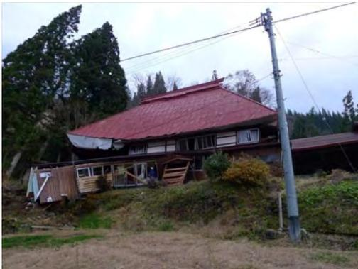
写真 6.1.1 部分的に崩壊した住宅
