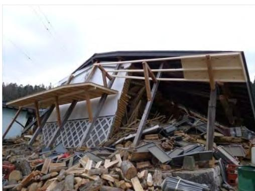
写真 5.3.22 倒壊した土蔵
