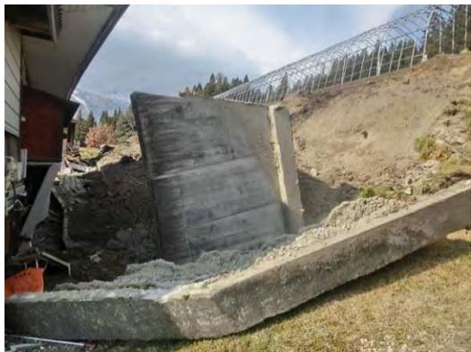
写真 5.1.23 北側の擁壁の崩壊
