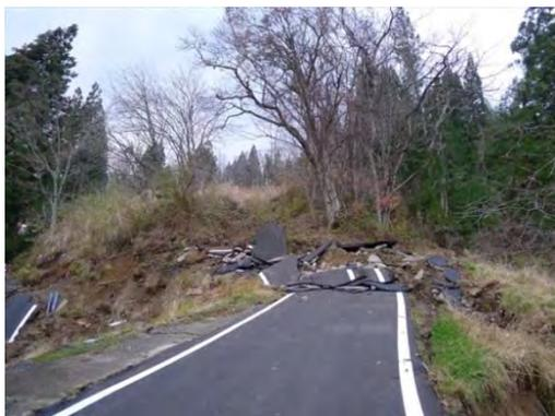
写真 6.1.3 土砂崩れによる道路の被害
