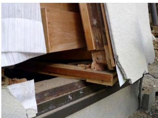
写真 5.3.8 柱の抜け出し
