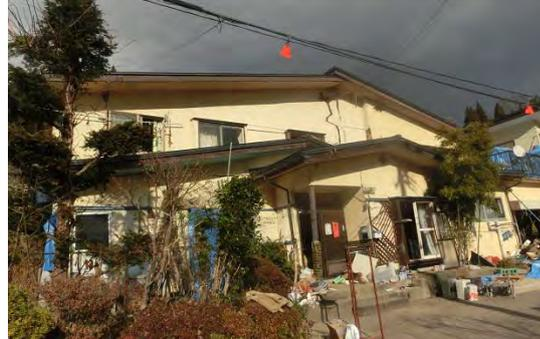
写真 5.2.15 西（写真左）へ傾斜した住宅
