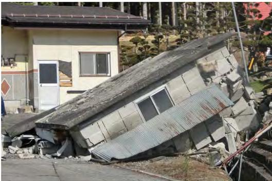
写真 5.1.24 コンクリートブロック造の崩壊
