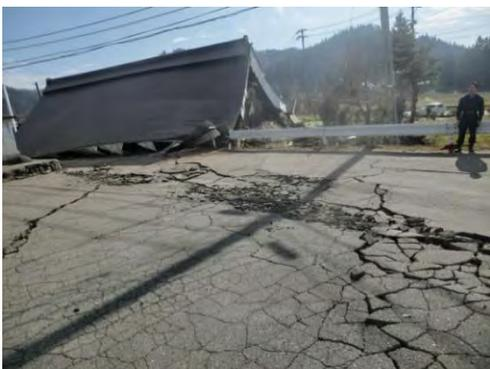
写真 5.1.4 激しく損傷した道路舗装
