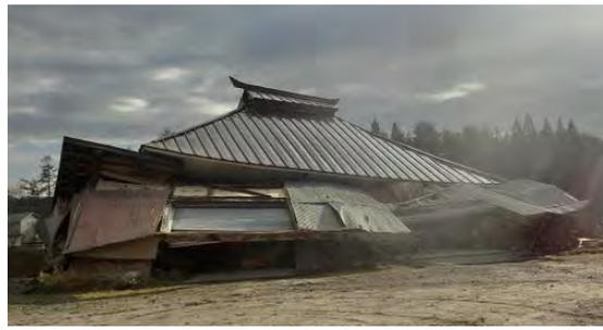
写真 5.2.5 倒壊した住宅
