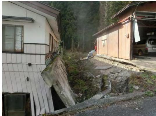
写真 5.2.7 崩壊した北側の擁壁
