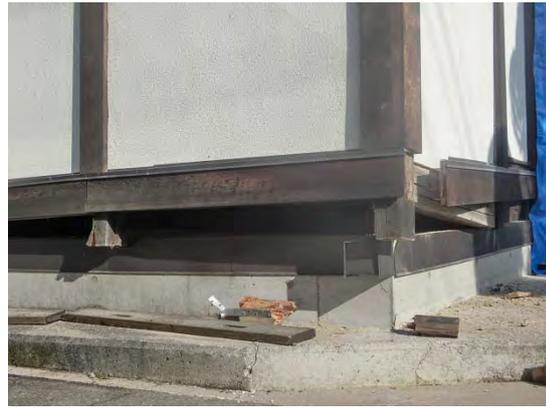
写真 5.2.11 土台を踏み外した柱脚
