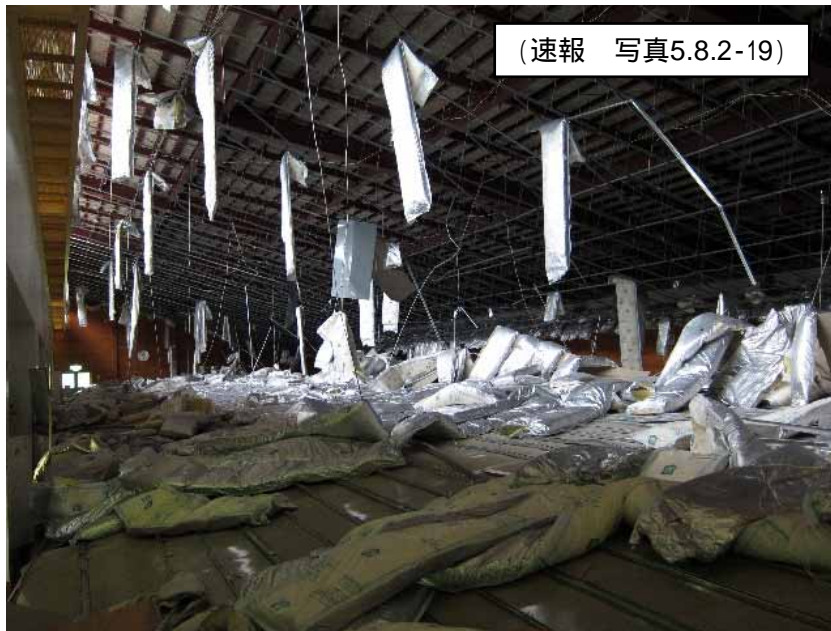
熊本市内(体育施設) 吊り天井部材の落下
