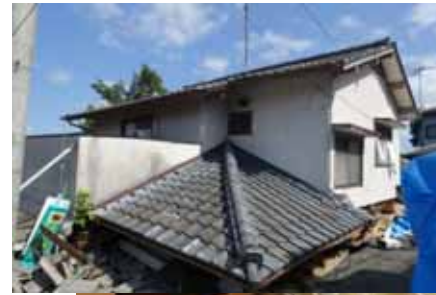
益城町(戸建住宅) 1階が崩壊
