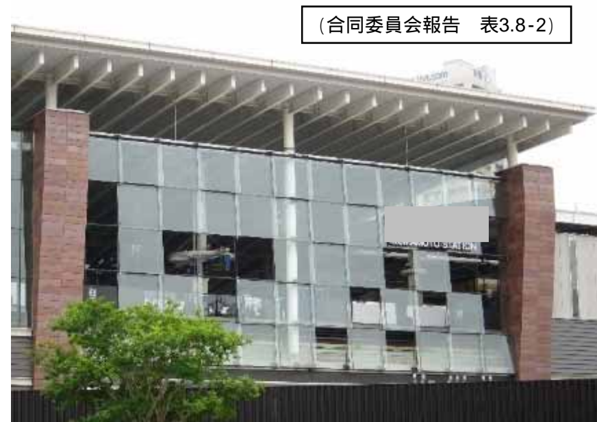
熊本市内(商業施設) 大判ガラス(DPG工法)の落下
