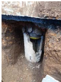
1984年5階建て公的な共同住宅 上部構造の被災度：軽微～小破 住民退去後、取り壊し
