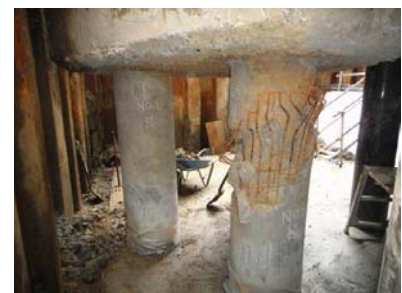
No.6, 7 (手前No.6) コンクリート既製杭の被害
