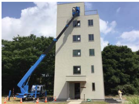
①高所作業(目視点検)
