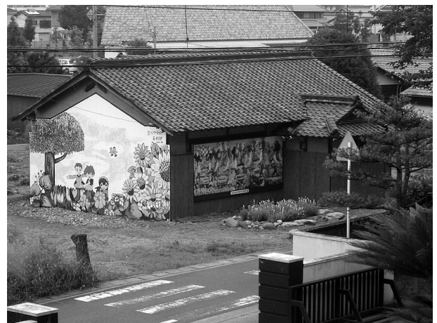
写真-2 地域力で改善された空き家（後）
