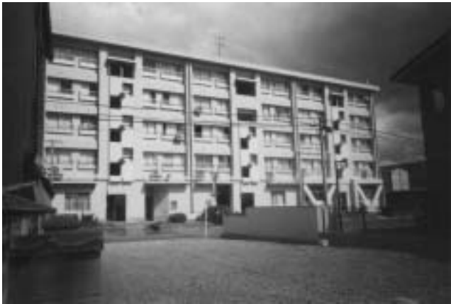
図19 粘弾性ダンパーによる共同住宅の制震改修 (株河池組提供)
