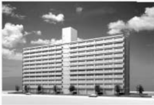
(d) 免震改修
