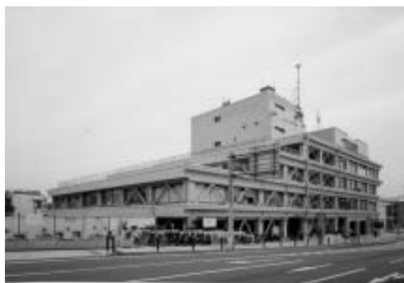
図18 鋼材ダンパーによる庁舎の制振改修 (株)日建設計提供
