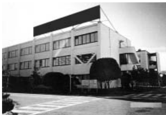
図17 鉄骨ブレースによる事務所建物の強度型改修 (株)ピーエス三菱提供
