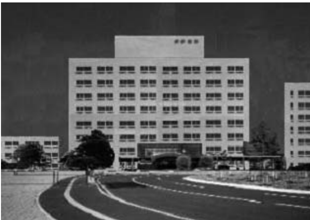
図20 粘性ダンパーによる病院の制震改修 (三井住友建設㈱提供)
