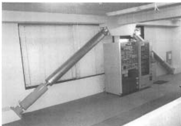
図21 オイル・ダンパーによる工場の制震改修 (株構造計画研究所提供)
