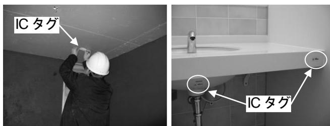
写真2 トイレ天井へのICタグの貼付
