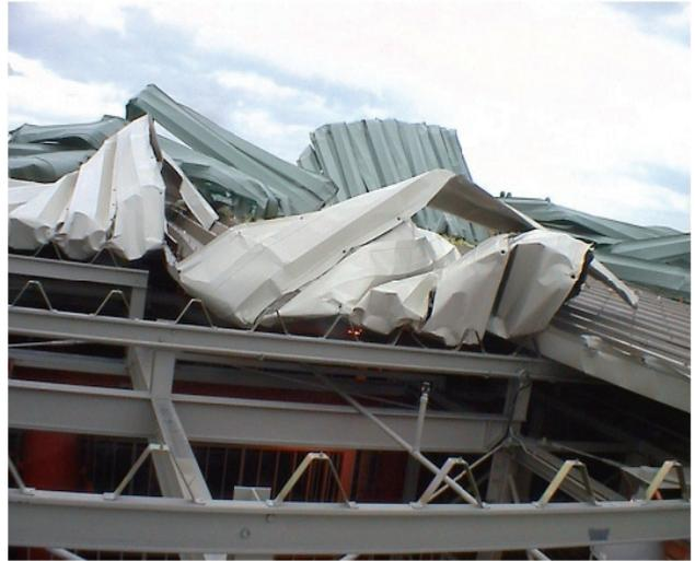
写真1 平成16年台風23号による鋼板製屋根の被害(西村宏昭氏提供)
