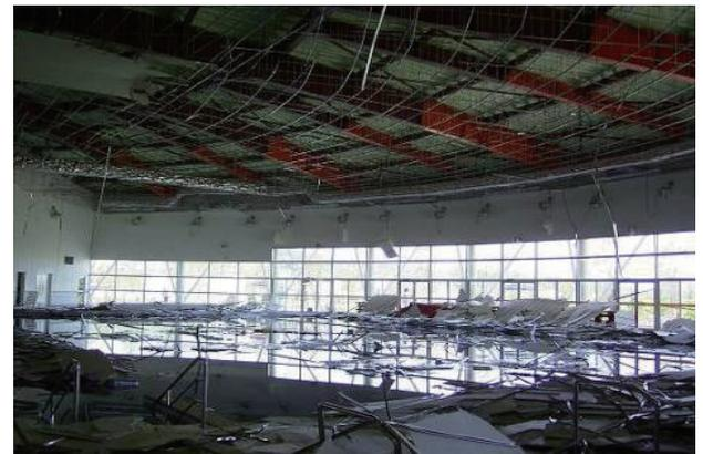
写真2 平成17年宮城県沖の地震における天井の被害
