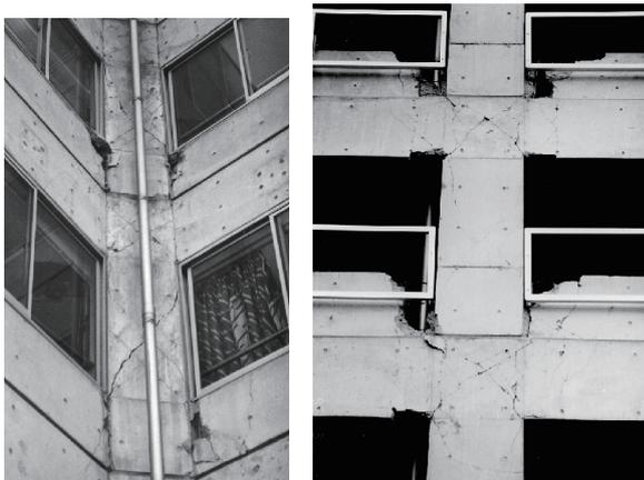
a) 柱のせん断破壊や損傷      b) 梁や柱梁接合部の損傷
