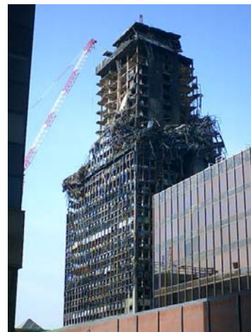
図2 火災で上部が崩壊した高層ビル
