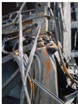
図1 火災の熱で大きく変形した鉄骨
