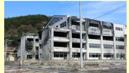
被災した大槌小学校
