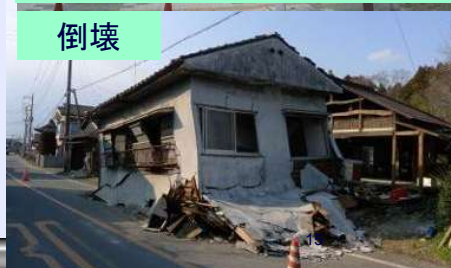
内装材・外装材の割れや脱落
