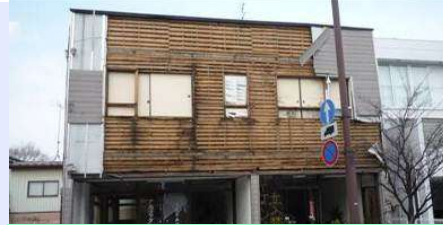
内装材・外装材の割れや脱落
