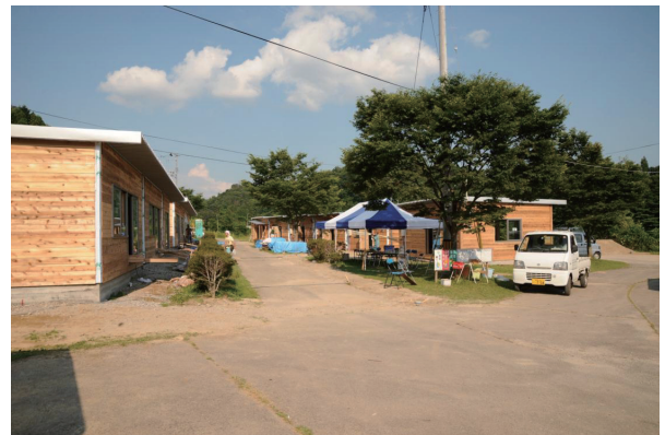
写真2 地元工務店によって建設された木造応急仮設住宅（福島県三春町）
