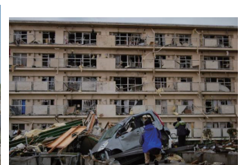
図6 広範囲にわたり外装材が損壊した5階建て集合住宅
