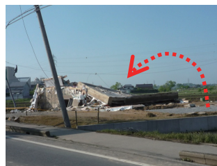
図5 基礎を伴って上部構造が転倒した木造住宅
