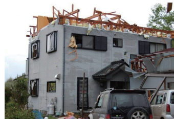
図3 木造小屋組の倒壊
