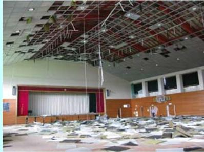
写真5.3-13 天井(システム)の落下
