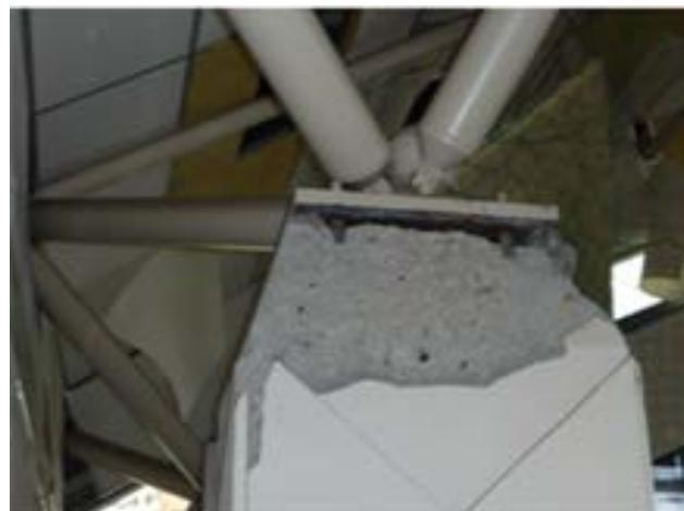
構造材定着部の損傷
