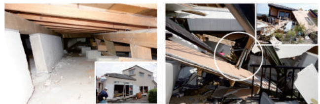
写真3 (左) 4 (右) 地盤変状が認められ基礎の損傷が顕著な事例(被害形態③)
