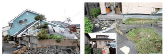
写真1 (左) 建物の倒壊により基礎ないし敷地全体の状況確認が困難な事例(被害形態①)
