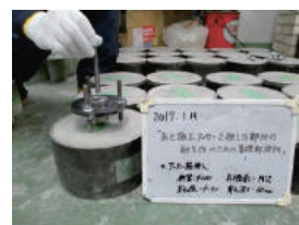
写真6 アンカー筋挿入状況
