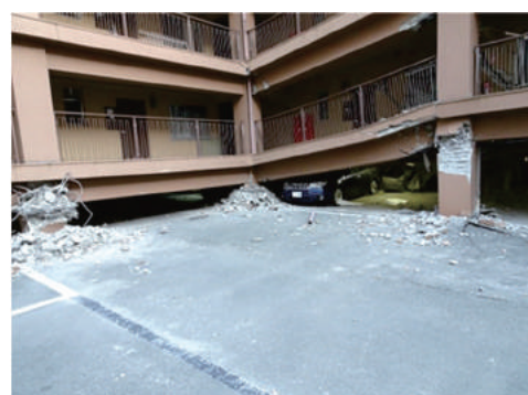
写真4 ピロティ層の層崩壊
