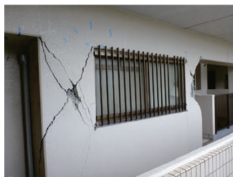
写真3 方立壁の損傷
