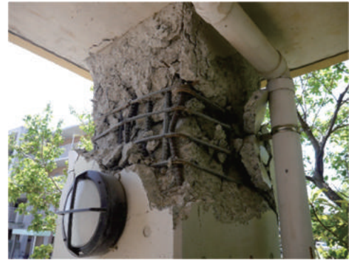
写真1 1階柱の柱頭部の被害
