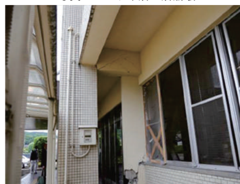
写真5 短スパン梁のせん断ひび割れ
