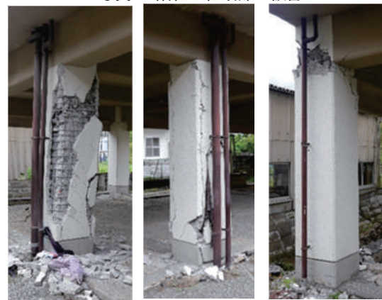
写真2 1階柱の脆性破壊
