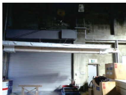
(2) 試験後の試験体の様子
