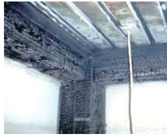
写真7 燃え止まり状況
