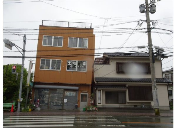
写真 2-10 3階建て商用建築物の沈下・傾斜
