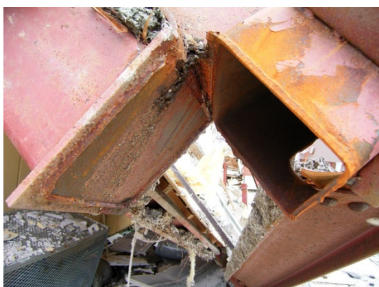
写真 2-2 倒壊した鉄骨造建築物の接合部の被害状況
