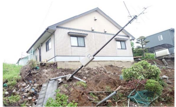
写真 2-8 盛土擁壁の被害 (図 2-9 の B1 地域)
