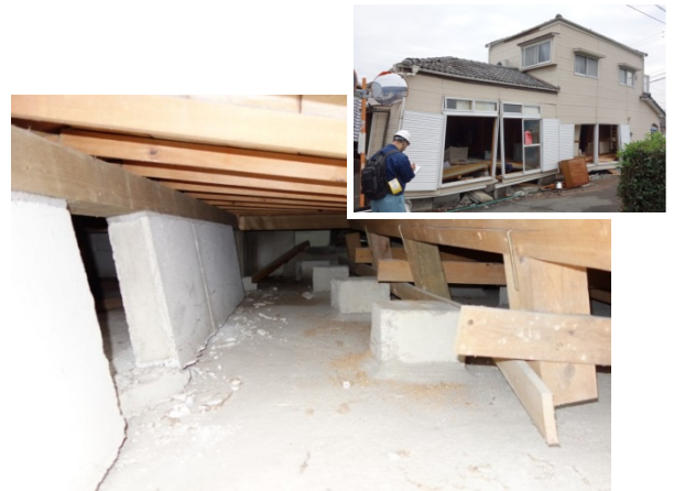
写真 2-9 地盤変状と基礎の損傷が共に見られた被害
