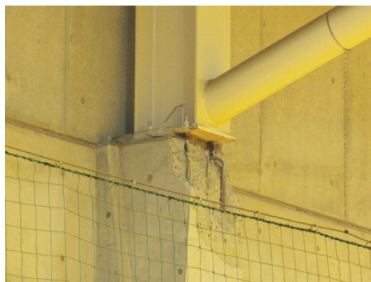
写真 2-3 屋根支承部のコンクリートの側方破壊
