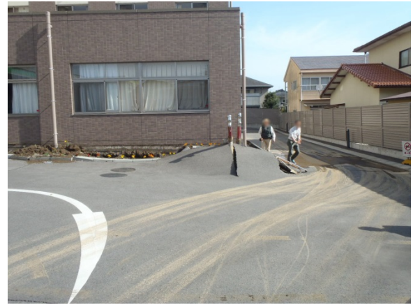
写真 2-11 建築物の周辺地盤の沈下
