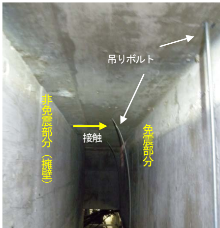
写真 2-15 配管用吊りボルトの変形
