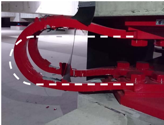
写真 2-14 鋼材部分の残留変形 (破線は原位置) と塗装のはがれ
