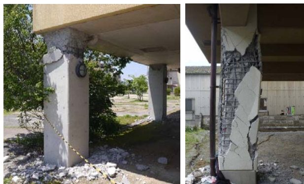
a) 柱頭部主筋の座屈・破断 b) 付着割裂破壊
