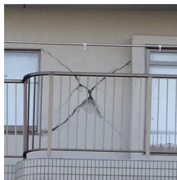
写真2-6 桁行き方向バルコニー側の方立て壁の被害状況
