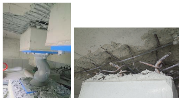
写真 2-12 ダンパー基部及び接合部 (定着) の被害
