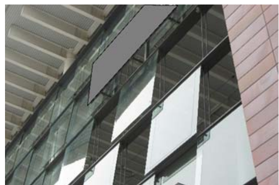
写真2-17 DPG構法によるガラス窓の被害（脱落）
