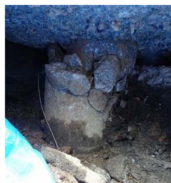
写真2-7 既製コンクリート杭頭部の損傷
