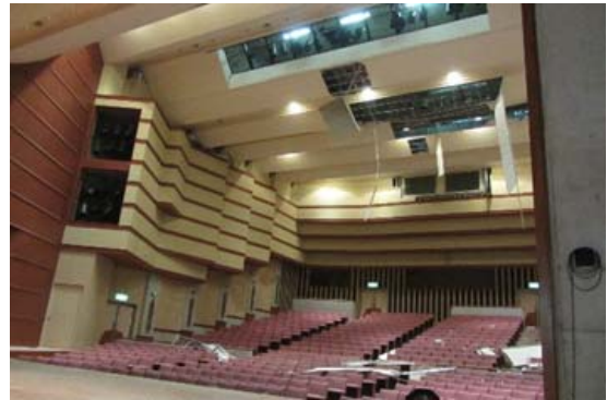
写真2-16 特定天井の条件に該当する吊り天井の被害
