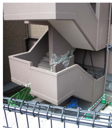
写真 2-13 外付け階段の被害
