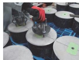
写真 5 アンカー筋挿入状況
