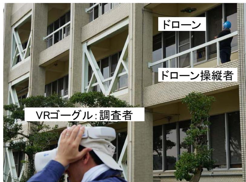
VRゴーグルを使用した構造躯体のひび割れ状況の確認
