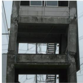
写真 6 本震後の3階柱脚部の損傷 (Ya2 構面)
