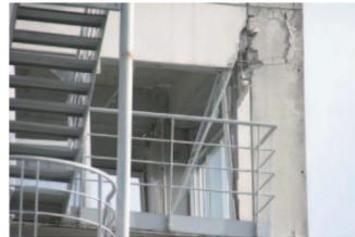
写真 11 本震後の5階柱梁接合部の損傷
