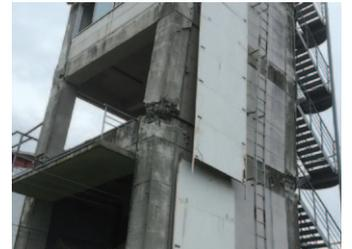
写真 8 本震後の3階部分の損傷 (Ya2 構面)
