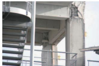
写真 10 本震後の4階柱梁接合部の損傷 (Ya1 構面, D)
