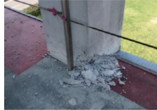
写真 3 前震後の3階柱脚の損傷 (Ya2 構面, B)
