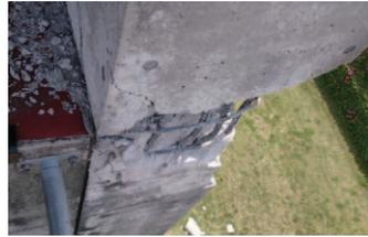
写真 2 前震後の3階柱梁接合部周辺の損傷 (Ya2 構面, A)
