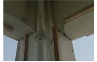
写真 4 前震後の4階大梁の損傷 (Ya1 構面, C)
