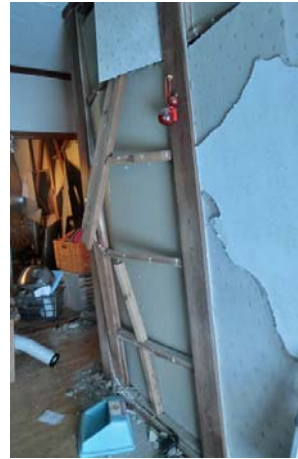
写真 4.4.2 座屈した筋かい
