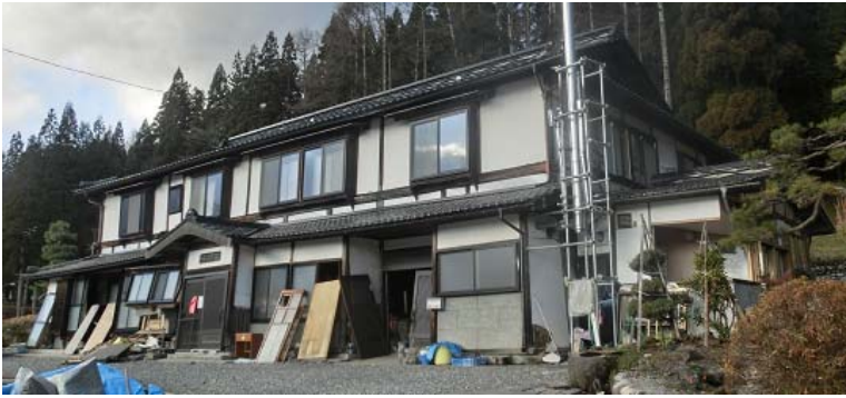
写真 4.2.1 建築物の外観
