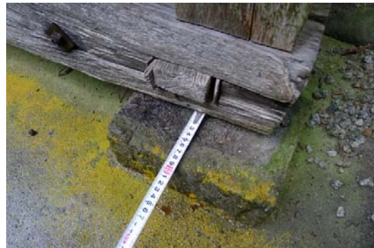
写真 5.1.4 土台のずれ
