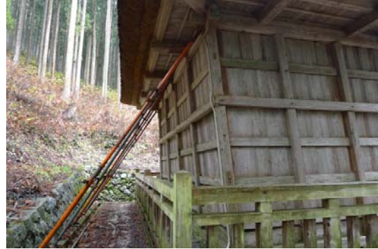
写真 5.1.2 大きく変形した覆屋
