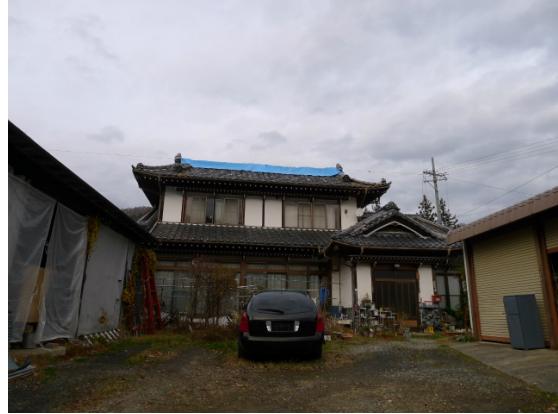
写真 5.4.2 ブルーシートに覆われた棟瓦
