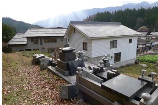
写真 4.6.4 山側の墓石と1FがRC造の倉庫
