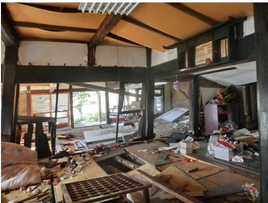
写真 4.2.3 詳細調査建築物の内部の様子
