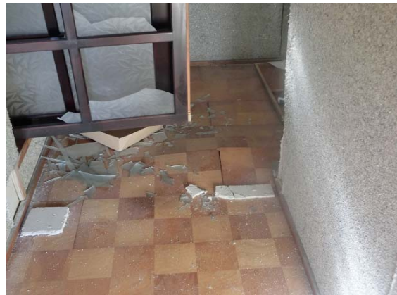
写真 4.2.4 面外に変形した 2 階の床板
