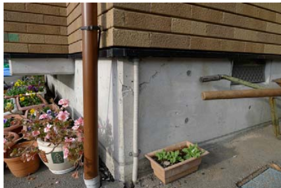
写真 4.6.2 基礎のひび割れ
