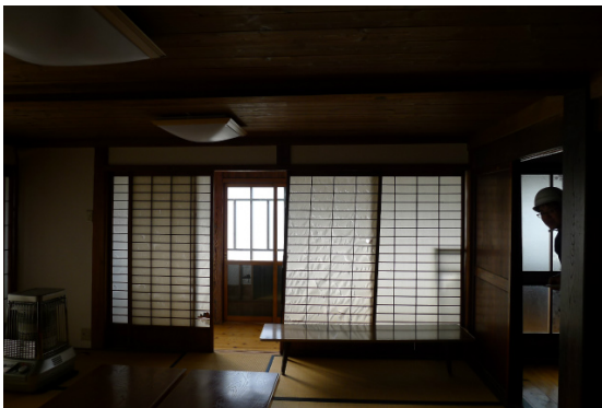
写真 4.7.3 障子の変形
