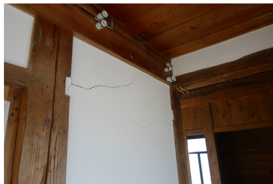
写真 4.7.2 土塗り壁のひび割れ
