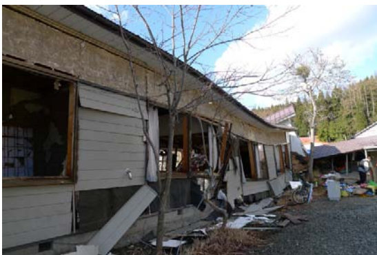
写真 4.1.3 東側の構面の変形
