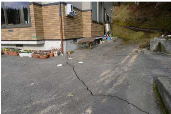
写真 4.6.3 アスファルトのひび割れ
