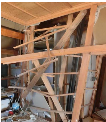
写真 4.5.3 座屈、破断した筋かい
