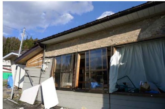
写真 4.1.2 モルタルと漆喰の剥落
