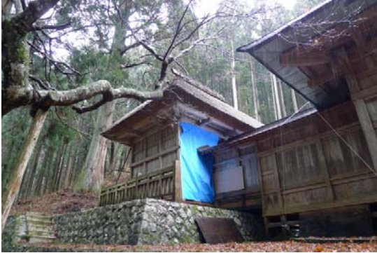
写真 5.1.1 本殿の覆屋の外観
