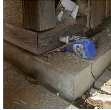
写真 4.2.2 亀裂が入った基礎 と水平移動した土台
