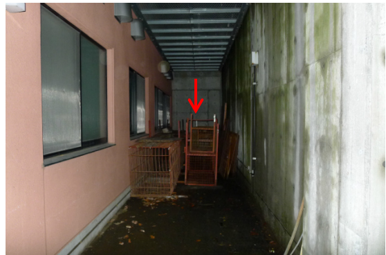
写真 5.5.2 鬼無里支所震度計の周辺状況
