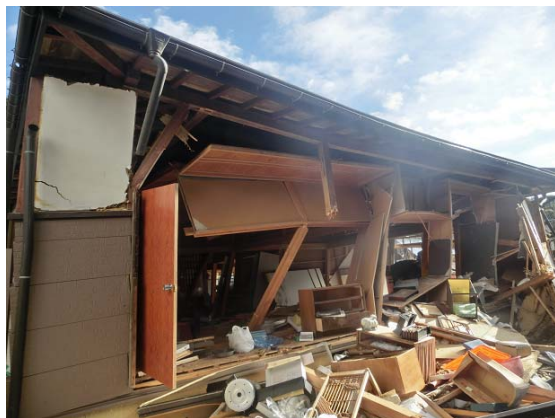
写真 4.5.4 大きく崩壊した西側壁線
