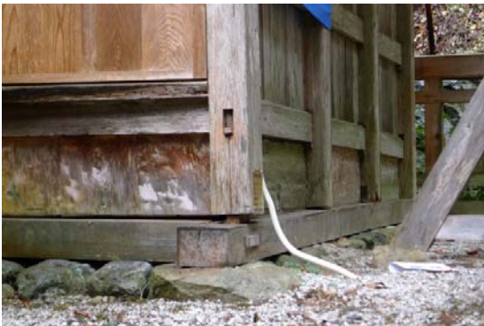
写真 5.1.3 覆屋の柱脚の浮き上がり
