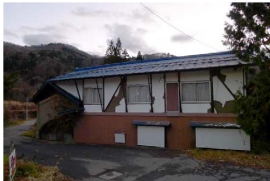
写真 5.2.4 仕上げが剥落した倉庫
