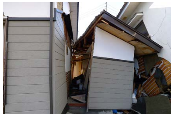
写真 4.1.4 増築部のずれ
