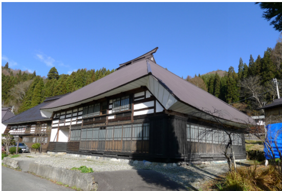
写真 4.7.1 建築物の外観
