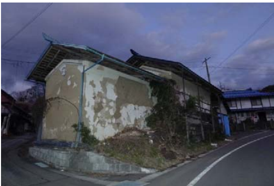
写真 5.2.3 仕上げが剥落した土蔵
