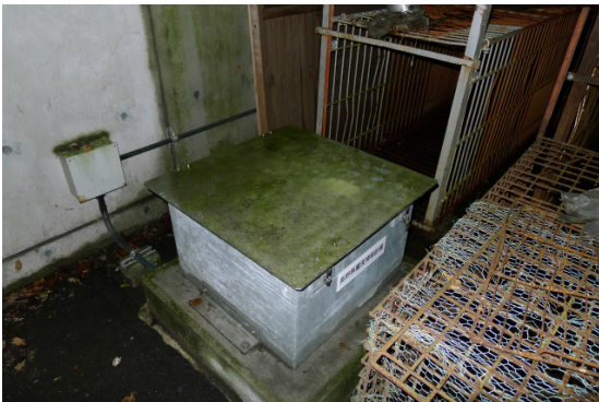
写真 5.5.1 鬼無里支所震度計設置状況
