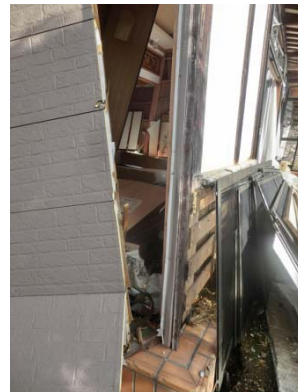
写真 4.5.2 土台を踏み外した柱
