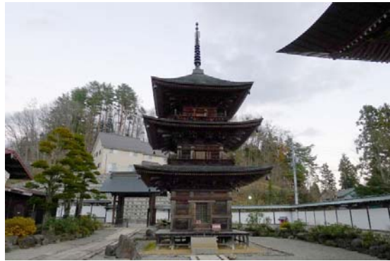
写真 5.2.2 外観上無被害の三重塔
