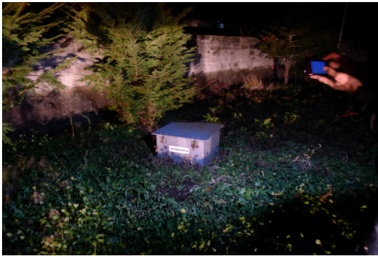
写真 5.5.3 戸隠支所震度計設置状況
