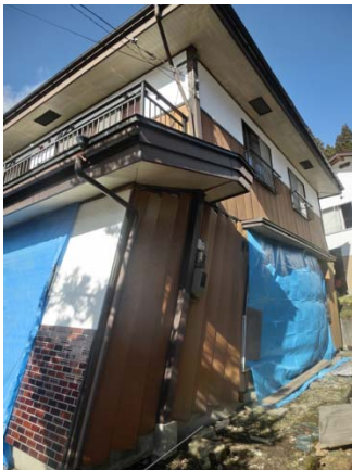
写真 4.4.3 金属版サイディングの変形
