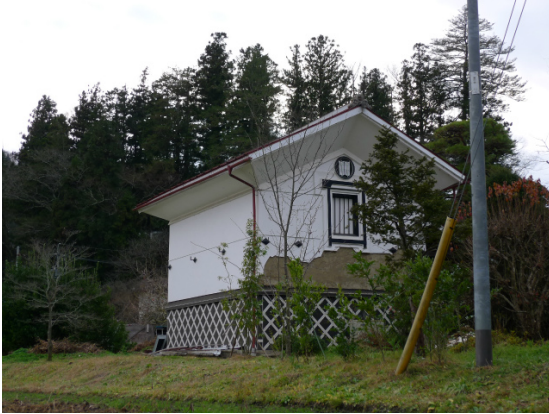
写真 5.4.1 土蔵の被害
