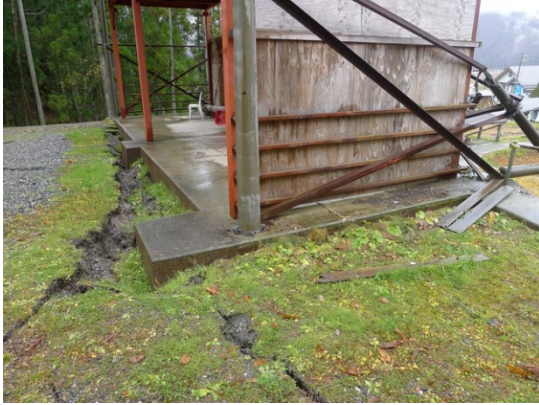
写真 5.3.25 写真 5.3.23 の鉄骨造構造物の基礎周りの地盤変状
