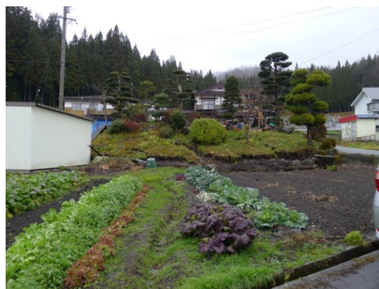
写真 5.3.20 南向き(写真の手前側)に崩壊した盛土擁壁
