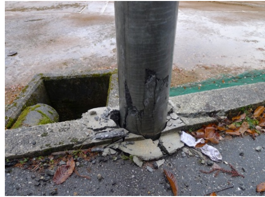
写真 A4 脚部が損傷した電柱：電柱の直径は脚部で約 24cm (堀之内東部)
