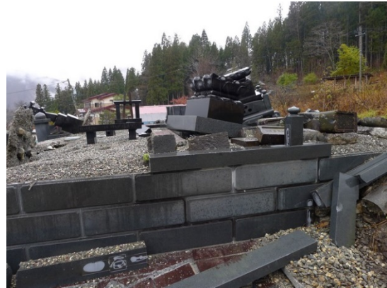
写真 5.1.2 墓地 B (堀之内西部) の墓石転倒状況
