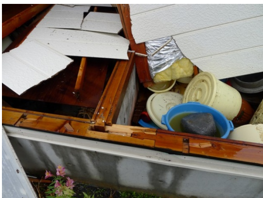
写真 5.3.3 倒壊した木造建築物の柱脚部：ほぞと打ち釘のみを確認できる
