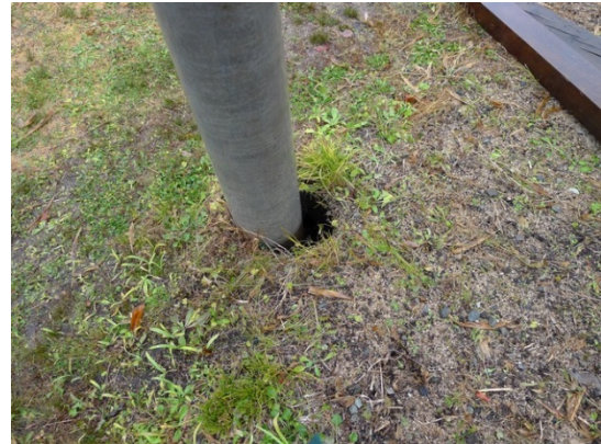
写真 5.3.6 写真 5.3.5 の電柱脚部：周辺地盤との隙間は北向き（写真の右向き）
