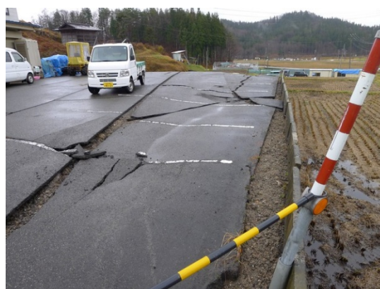
写真 5.3.22 西向き(写真の右向き)に変位した盛土擁壁
