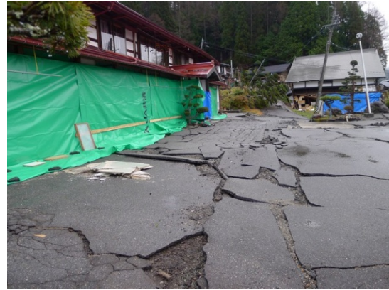
写真 5.3.12 大破した木造建築物とその敷 地の舗装の損傷:南向き(写真 の右向き)に亀裂が広がって いる
