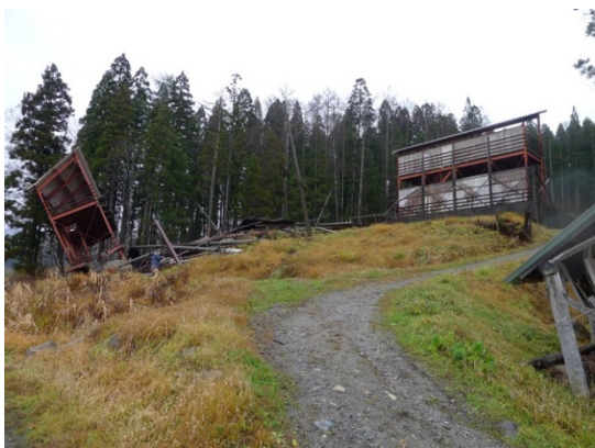
写真 5.3.23 地盤の崩壊・流動により斜面を滑落した鉄骨造構造物
