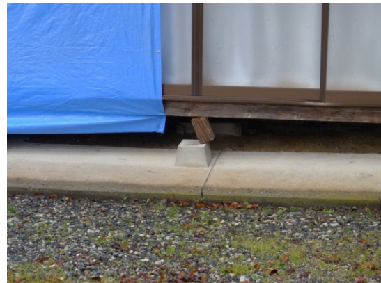
写真 5.3.28 木造住宅の床束のずれ (三日市場の北部)
