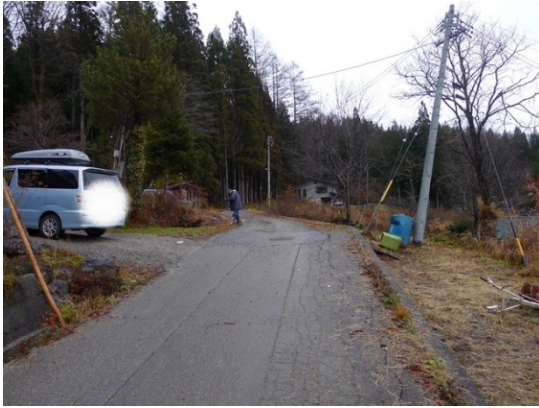
写真 A3 南向き (写真の右向き) に傾斜した電柱 (堀之内西部)
