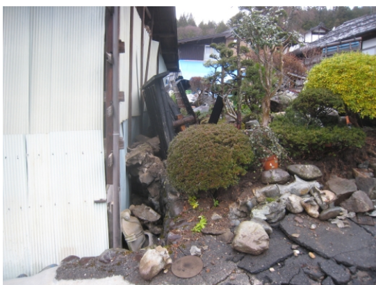
写真 5.3.19 南向き(写真の左向き)に被災した擁壁
