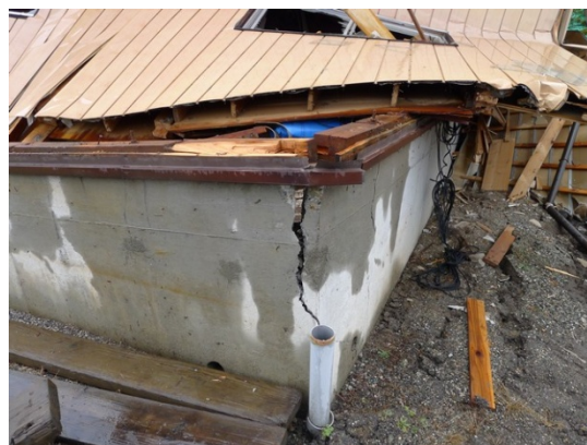
写真 5.3.4 基礎の立ち上がり部の損傷：無筋と思われる
