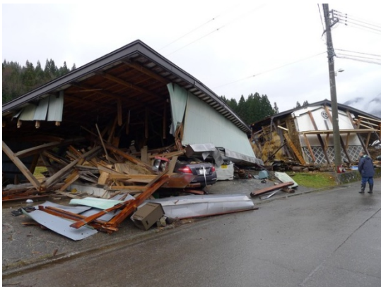
写真 5.3.27 南向き (写真の奥側) に倒壊した倉庫 (三日市場の北部)
