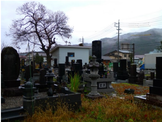
写真 5.1.1 墓地 A (神城駅付近) の墓石転倒状況
