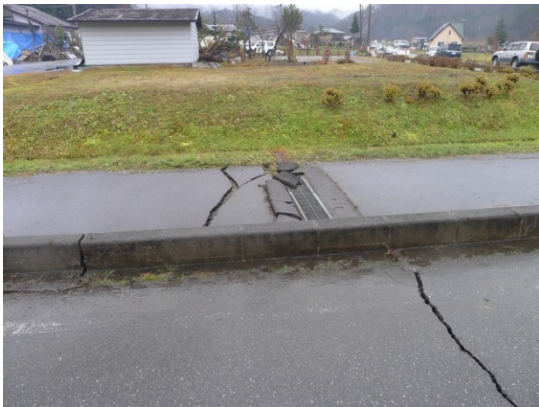
写真 5.3.13 道路の舗装の損傷:南北方向 (写真の左右方向)に力が作用 したように見える
