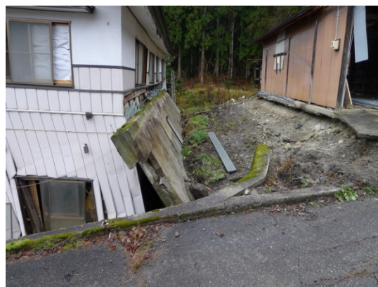
写真 5.3.18 南向き(写真の左向き)に転倒した擁壁
