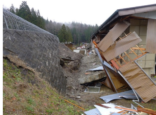
写真 5.3.8 南向き（写真の右向き）に転倒した擁壁と崩壊した地盤
