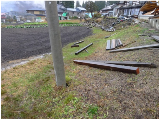
写真 5.3.5 南向き（写真の左向き）に傾斜した電柱
