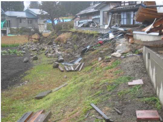
写真 5.3.7 南向き（写真の左向き）に崩壊した石垣
