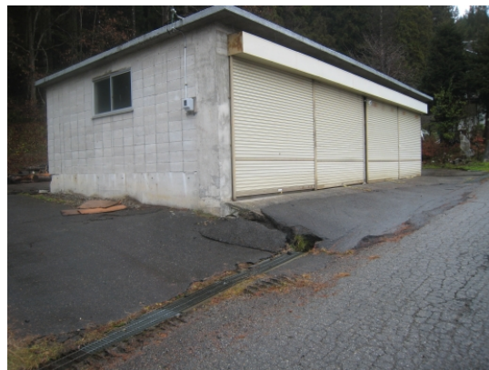
写真 5.3.16 コンクリートブロックの壁を有する倉庫（無被害）
