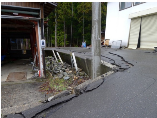
写真 A1 南向き（写真の左向き）に変位した盛土擁壁（堀之内東部）
