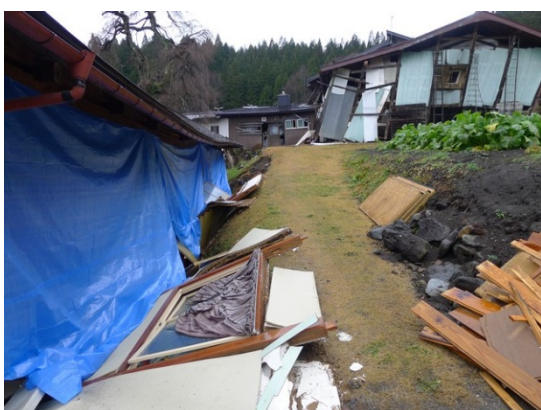
写真 5.3.21 北向き(写真の右向き)に変形した建築物
