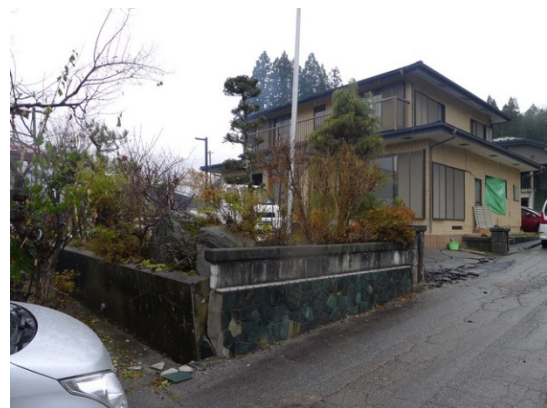
写真 5.3.10 南向き（写真の左向き）に変位した宅地擁壁
