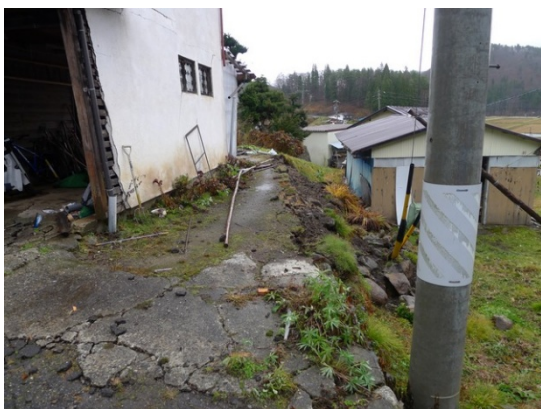
写真 5.3.17 南向き(写真の右向き)に崩壊した石垣
