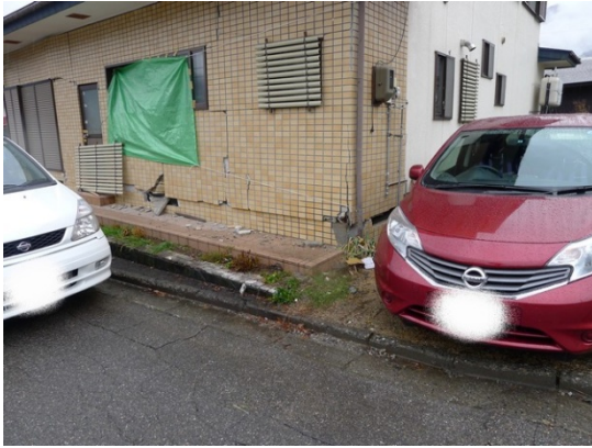
写真 5.3.11 写真 5.3.10 の木造住宅の被害 (小破程度)
