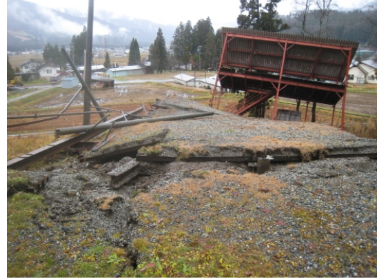
写真 5.3.26 地盤の崩壊・流動により鉄骨造構造物の支柱とスラブの支持力が喪失したと見られる
