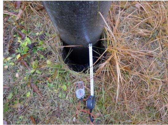
写真 A6 電柱の傾斜方向および電柱一周辺地盤間の隙間量の測定
