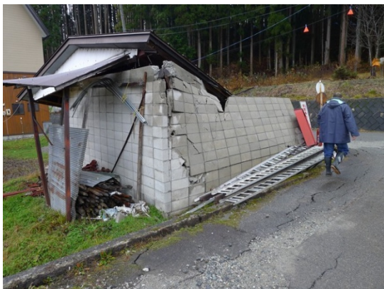
写真 5.3.15 コンクリートブロックの壁を有する倉庫（大破）
