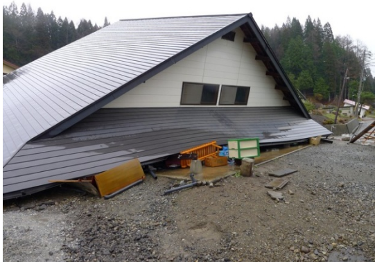
写真 5.3.1 1階が崩壊した木造建築物
