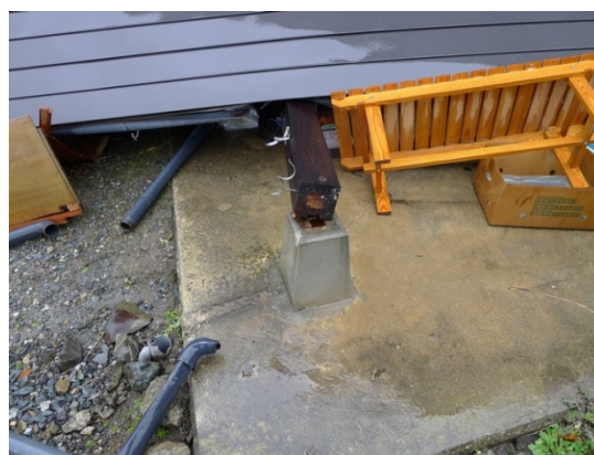
写真 5.3.2 写真 5.3.1 の柱脚部：柱は礎石に固定されず置かれていただけと思われる
