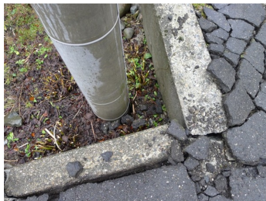
写真 A2 写真 A1 の電柱脚部:周辺地盤との隙間が生じている（堀之内東部）
