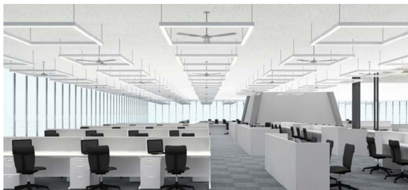
LED組込み照明とシーリングファン内観
