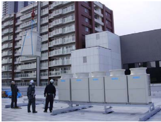
ヒートポンプ室外機搬入
