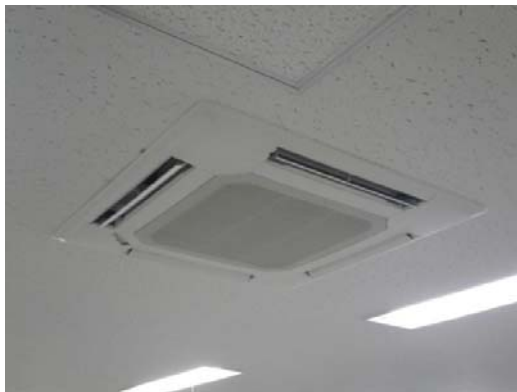
ヒートポンプ室内機
