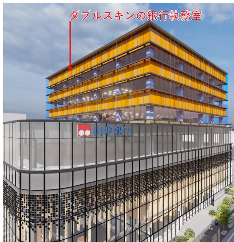
自動制御の電動オペレーター、太陽自動追尾型の電動外ブラインドによる
