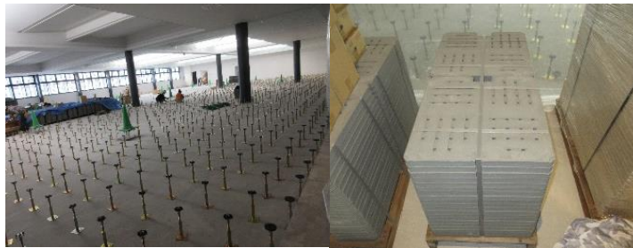
二重床施工状況
