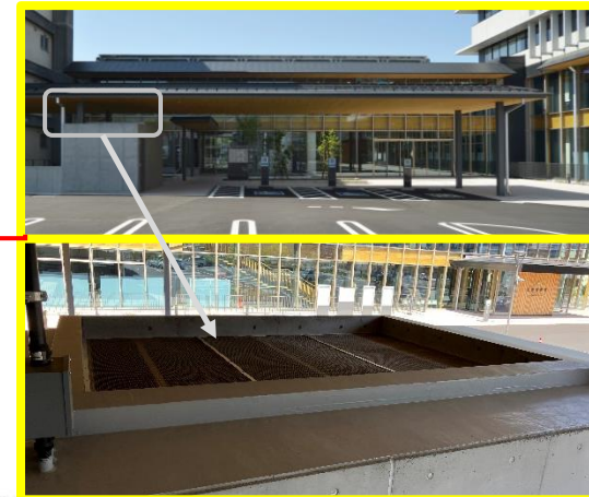
外気取入 地上・給気塔より 連結棟前の給気塔と外気取入口
