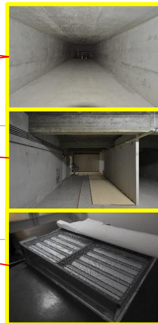
外気取入 地上・給気塔より 連結棟前の給気塔と外気取入口
