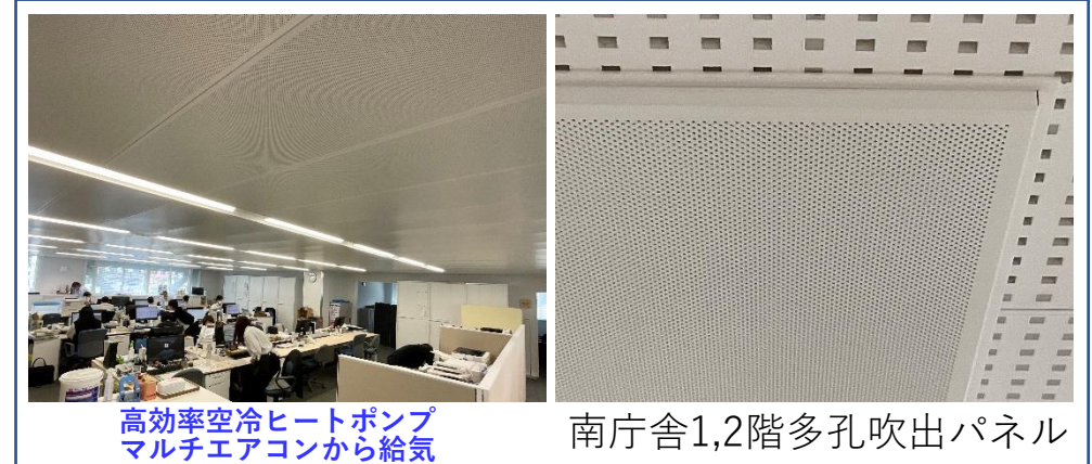
本庁舎2階執務室 多孔吹出アルミパネル
