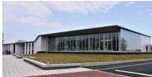
もりやまエコパーク交流拠点施設 (R2竣工) : エネルギー融通
