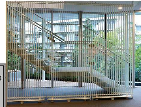
除湿型放射パネル (壁扱い ルーバー型)
