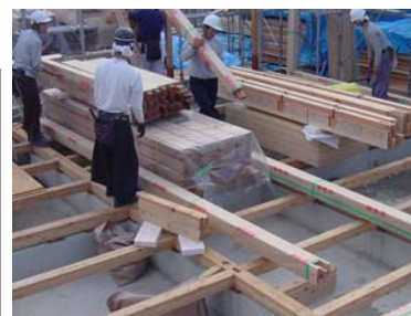
設備配管の点検交換可能な床下空間の確保
