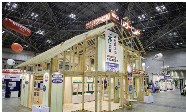
構造躯体には集成材と接合金物による弊社オリジナルの「パワービルド工法」を採用
