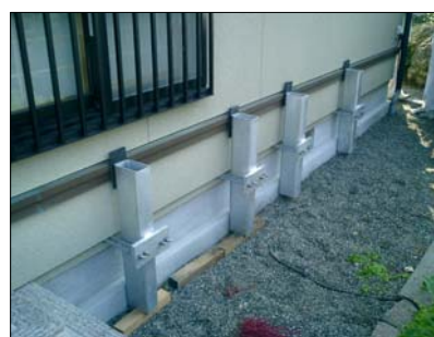
図 2.床下作業中は建物を固定する
