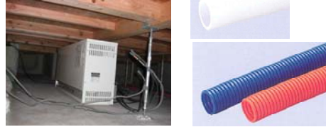
床下空間の様子とサヤ管材料
