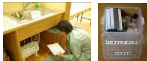
点検風景とメンテナンスボックス
