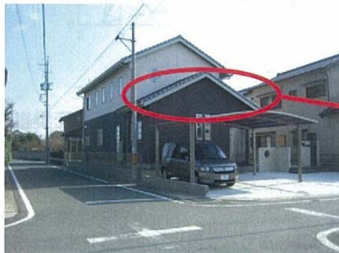
写真：小屋裏空間の利用
