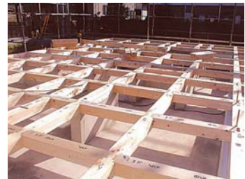
土台・大引組立状況
