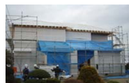
↑2日目の様子 上棟は2日工程です。
