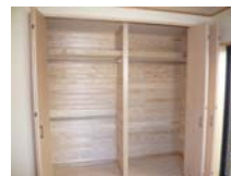
収納内部杉板貼(羽目板)
