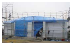
↑1日目の様子 2日目に備え、桁上に ブルーシートを施工します。
