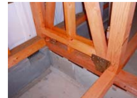
耐震補強、基礎補強
