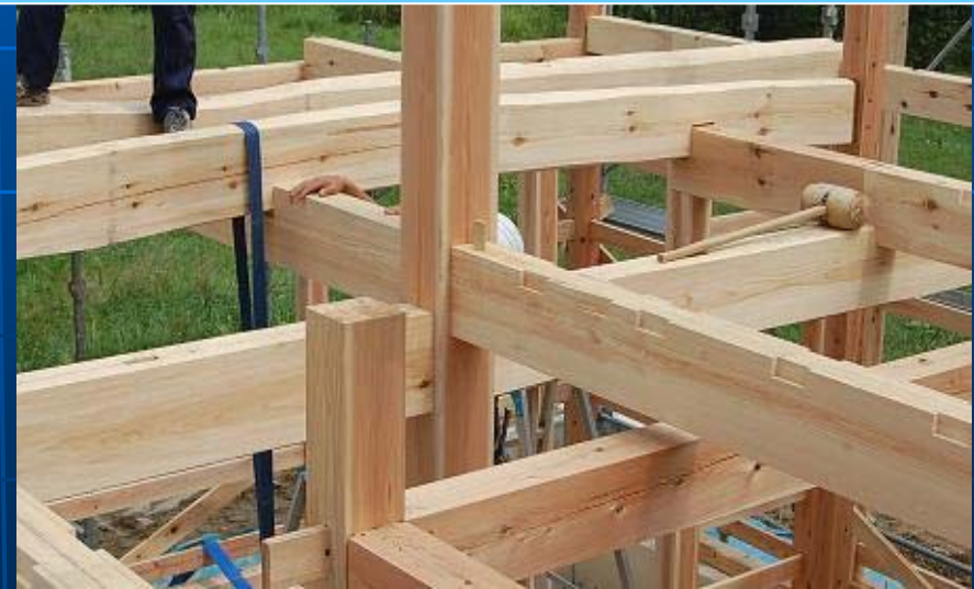
5.5寸通し柱へ車知栓四方差・他渡り顎掛
