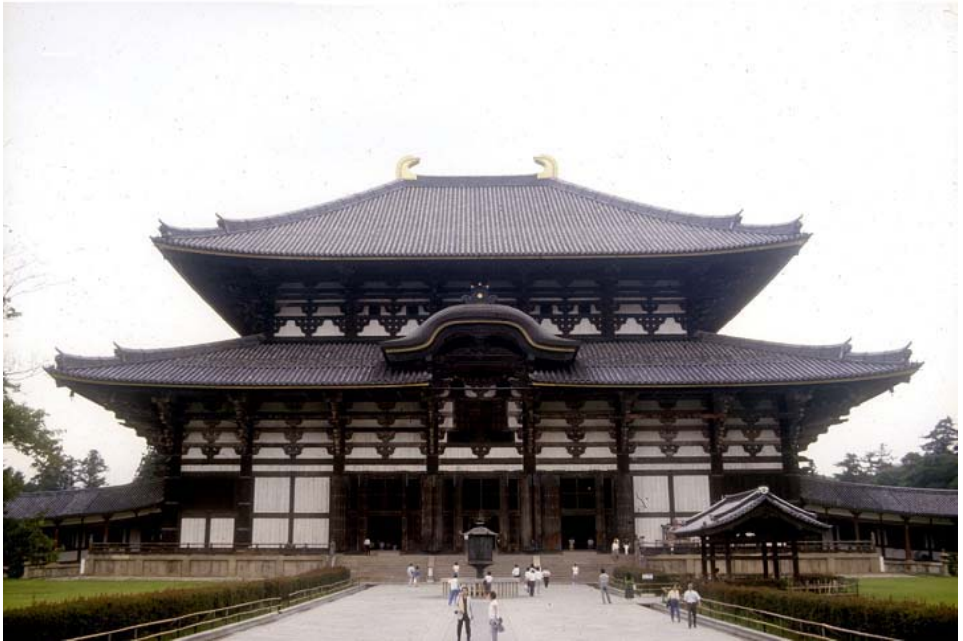
伝統木造建築(東大寺)
