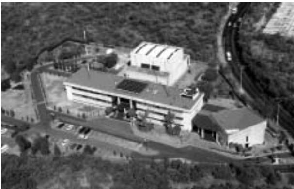
写真－2 国立防災センター全景
