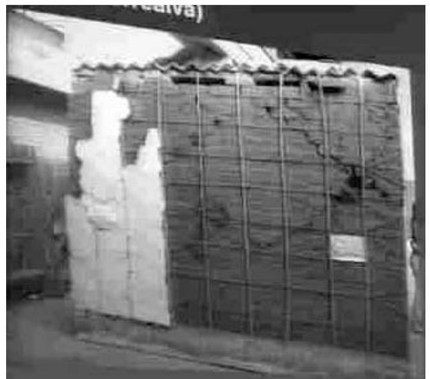
写真 15 カーニャを格子状に配置する補強方法を示すスライド
