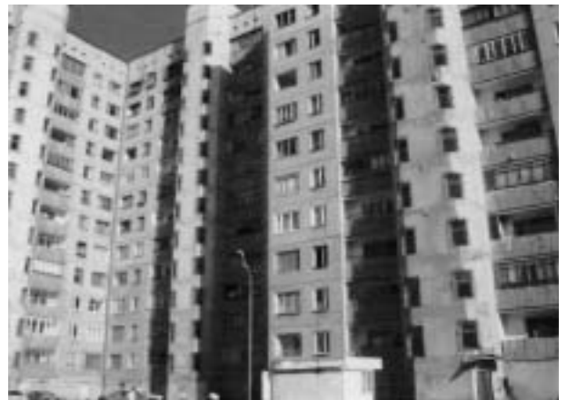
図 5 アルマティ市内の10層集合住宅（公務員住宅）
