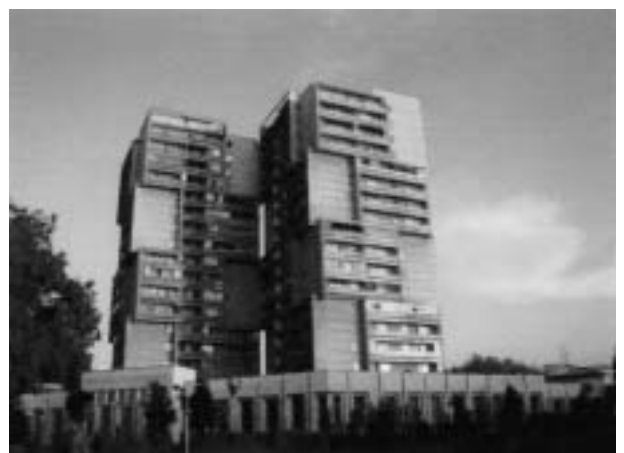
図 6 アルマティ市内中心部の16層集合住宅
