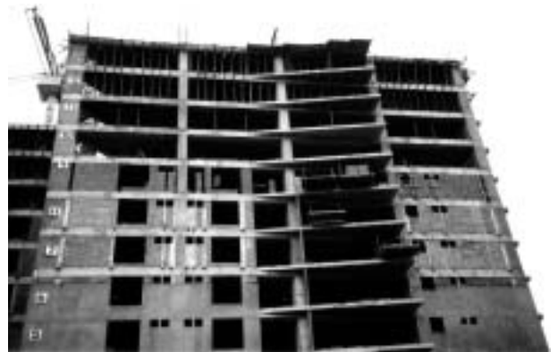
図 10 ペルーの典型的な高層建築物の構造
