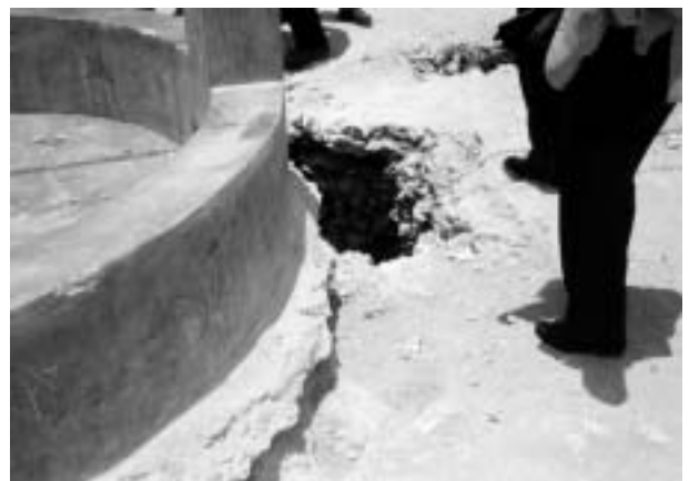
図 8 水呑場の給水管のそばで崩壊土の地盤に穴があいた例（ペルー南部マヘス市）
