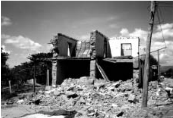
図 13 タピアル造の地震被害（1990年リオ八地震）
