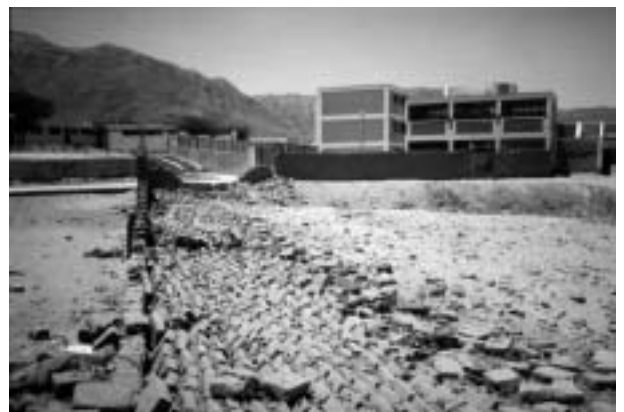
図 11 アドベ造の塙の地震被害（1995年ナスカ地震）
