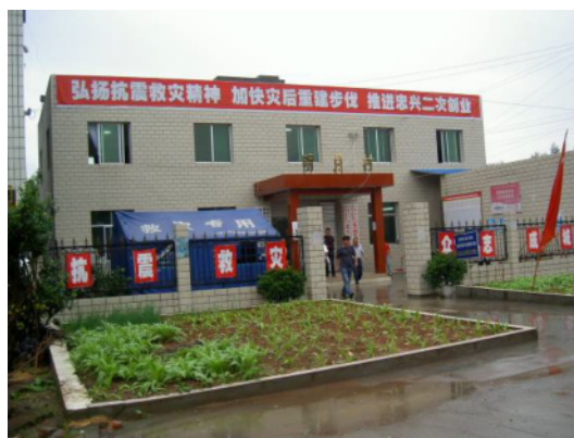
写真付 4.4 鎮の仮庁舎（綿陽市忠興鎮）
