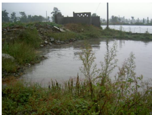
写真付 4.5 建設予定地（綿竹市九龍鎮）
