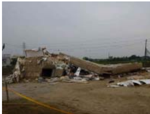
写真 1 転倒した木造建築物
