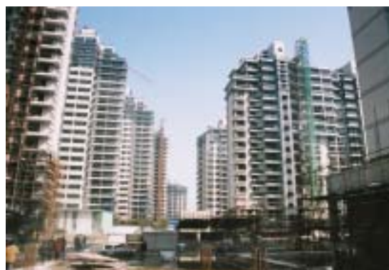
建設現場概況
