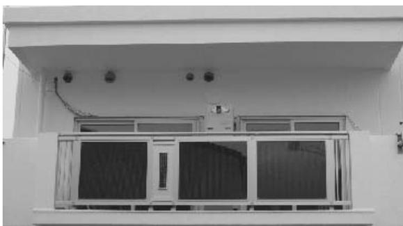
写真 1 手すり一体型ユニット設置状況
